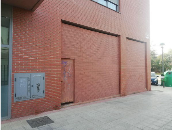
Fachada calle Enrique Granados.
