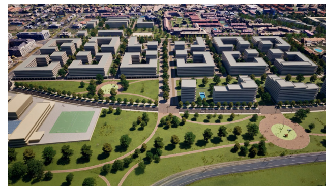
■ Simulación virtual de la intervención en Ramblasque que permitirá nuevas viviendas y dotaciones pública.
