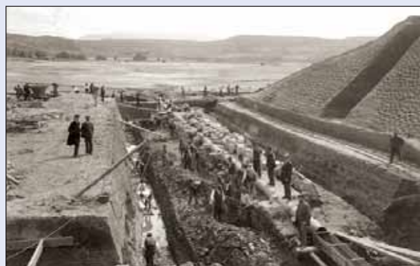
Obras de recrecimiento del dique del Pantano de la Grajera.
