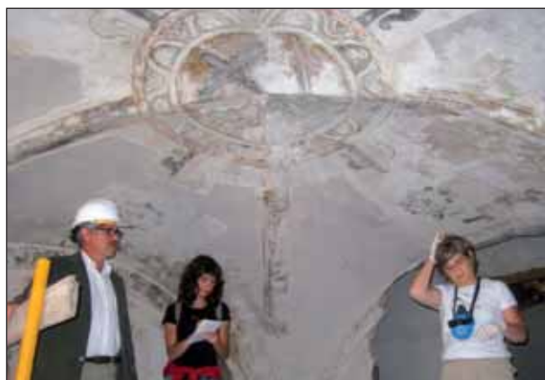
La rehabilitación ha dejado al descubierto las pinturas murales.
